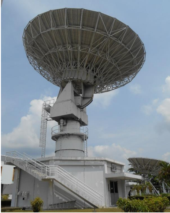
Gambar 3. Antena JAH-5A berdiameter 18,3m yang sangat potensial untuk dimanfaatkan sebagai teleskop radio VLBI untuk aplikasi geodesi/geodinamika.
