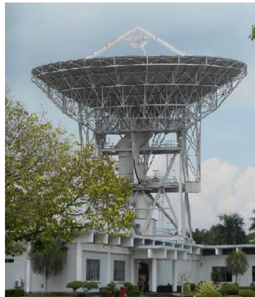
Gambar 2. Antena JAH-2A berdiameter 32m yang sangat potensial untuk dimanfaatkan sebagai teleskop radio VLBI untuk aplikasi astronomi/astrofisika.
