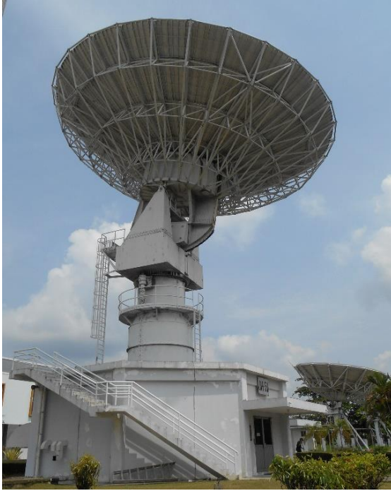
Gambar 3. Antena JAH-5A berdiameter 18,3m yang sangat potensial untuk dimanfaatkan sebagai teleskop radio VLBI untuk aplikasi geodesi/geodinamika.
